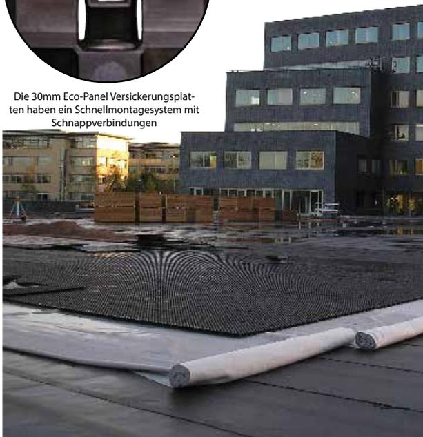
Verlegung von 30mm GEP Eco-Panel Platten unter einer befahrbaren Straße
