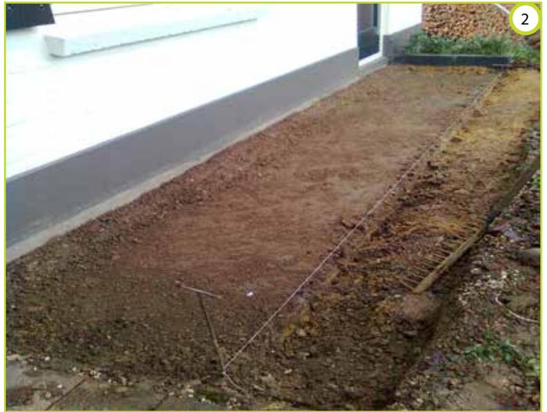
Aushub für ein separates GEP Versickerungsrohr zur schnellen Entwässerung
