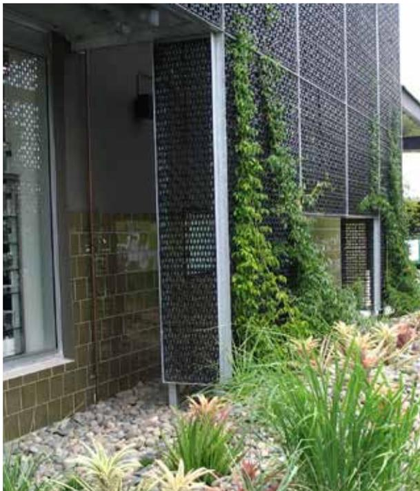
GEP 52 mm Drainageplatten vertikal eingebaut in einem vertikalen Garten
