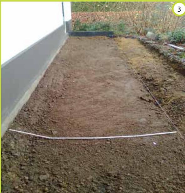
Verdichtete und leicht schräg abfallende Fläche für die GEP Eco-Panel Versickerungsplatten und Versickerungsrohr
