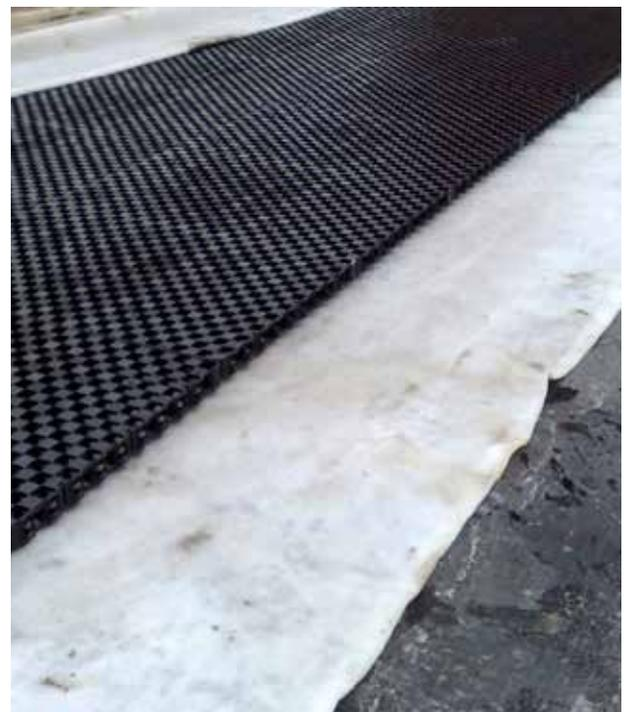
Verlegung von 30mm GEP Eco-Panel Platten unter einer befahrbaren Straße
